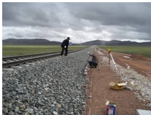
(a) 路基结构测线布置
